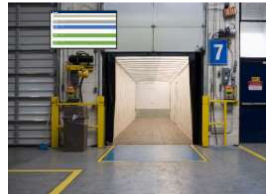
Anzeige der zukünftigen Zeitfenster direkt an der Rampe
